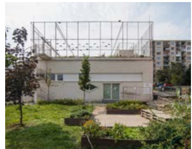
Výmenníky SPOTs, Košice
